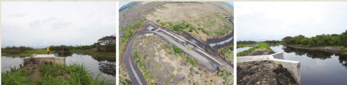
Figura 3. Construcción de compuertas Quebrada La Mula para control de ingreso de agua (En la época de lluvia las compuertas están abiertas para que ingrese el agua de lluvia por el cauce de la quebrada la Mula)
